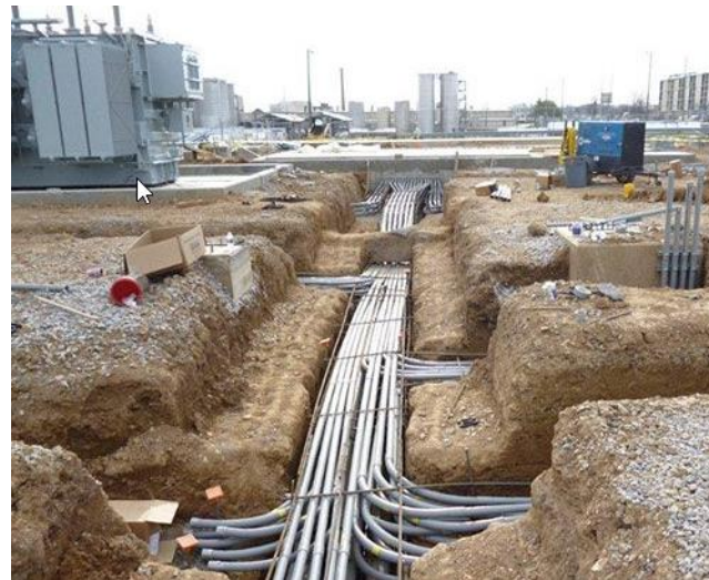
Figure A: U/G Conduit Example
